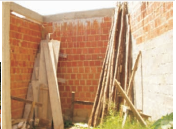
Visão interna da construção
